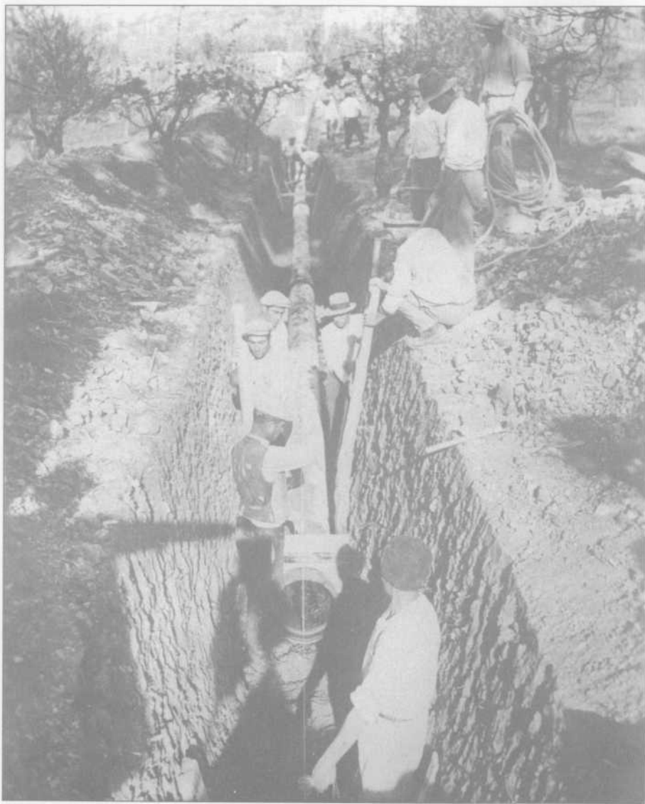
Foto anni '30 - Captazione delle Sorgenti del Ruzzo - Opere di adduzione delle condotte
