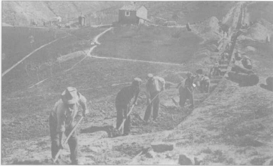
Foto anni '30 - Captazione delle Sorgenti del Ruzzo - Lavori di adduzione delle tubature
