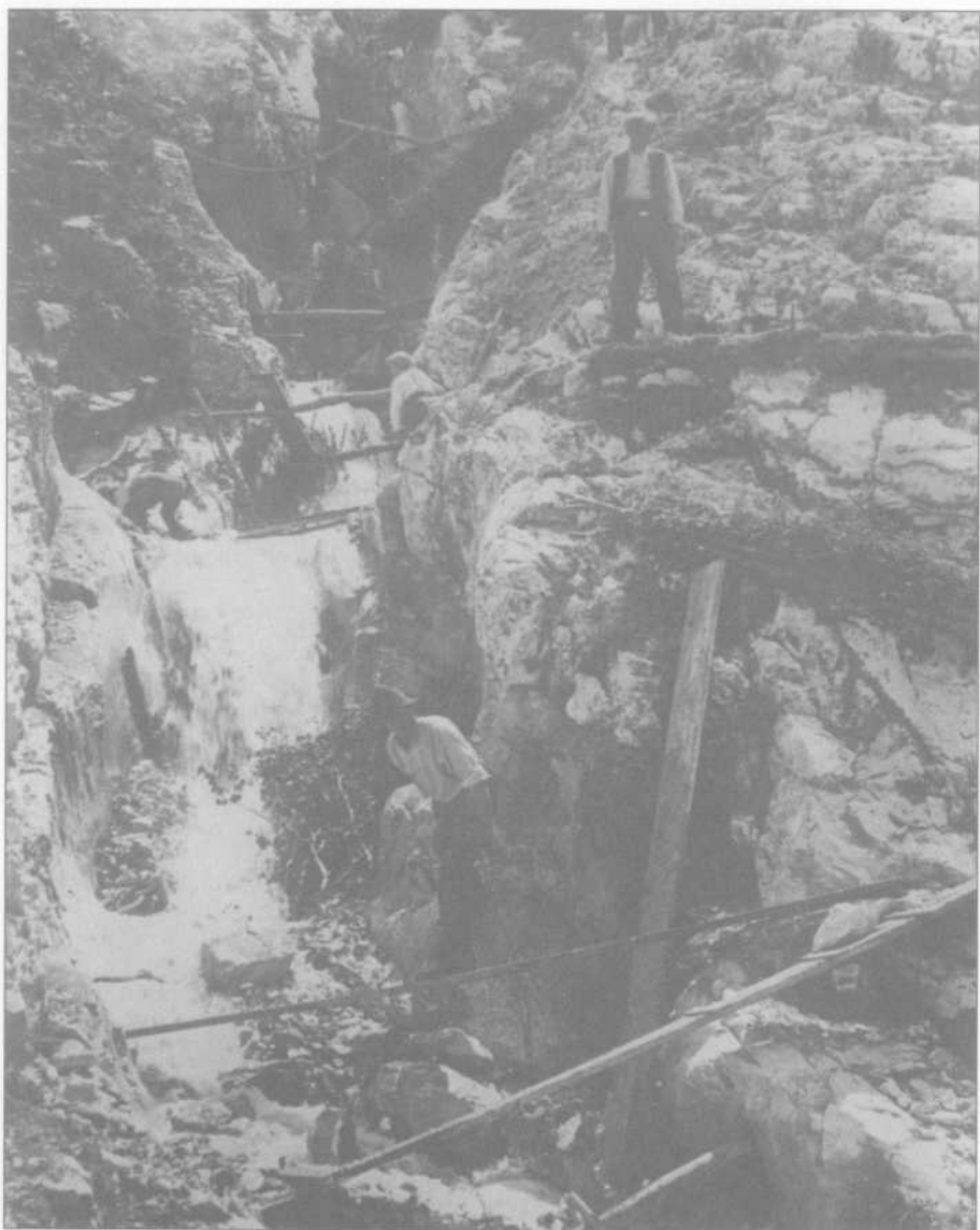
Foto anni '30 - Lavori di captazione delle Sorgenti del Ruzzo nel Vallone di Fossaceca
